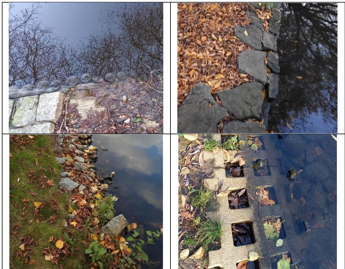
Abb. 4: Abgeflachte Ufer mit Verbau
